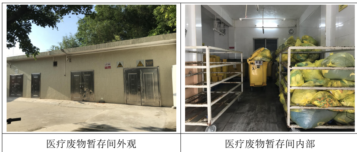
图 3.3-4 现有项目危废车间实拍图
